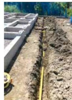
敷地境、建物の位置、ガス管の引込位置など、図面を確認し、埋設深度の基準、安全を遵守し掘削・施工しました。費用はガス管の長さによって変わってきますので、ご相談ください。
