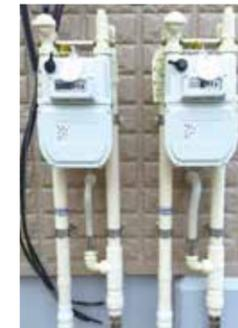
二世帯住宅への設置ということで、2台設置。支持金具にステンレス製のものを使用したり、高さ・間隔にもこだわって取り付けしました。都市ガスのメリットは省スペースであることとガス漏れなどがしにくく安全であることです。
